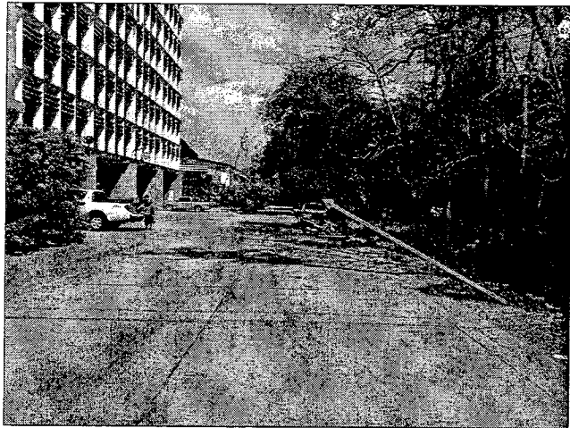
10. งานรื้อถอนถนนแนว J
