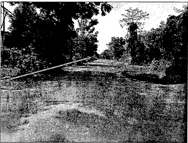
3. งานรื้อถอนถนนแนว C
